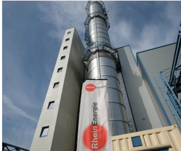
Heizkraftwerk der Rhein-Energie in Niehl (Grönert)
