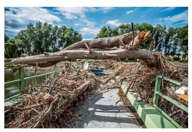
Das Hochwasser der Wupper hat mit extremen Kräften auf die Brücke eingewirkt. Anschließend sah es ziemlich wüst aus. (Ralf Krieger)
