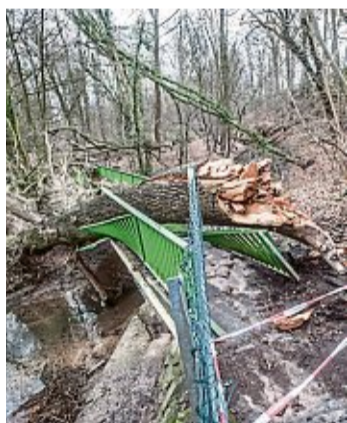
Die Brücke an Sanderschopp nach dem Sturm im Februar.
