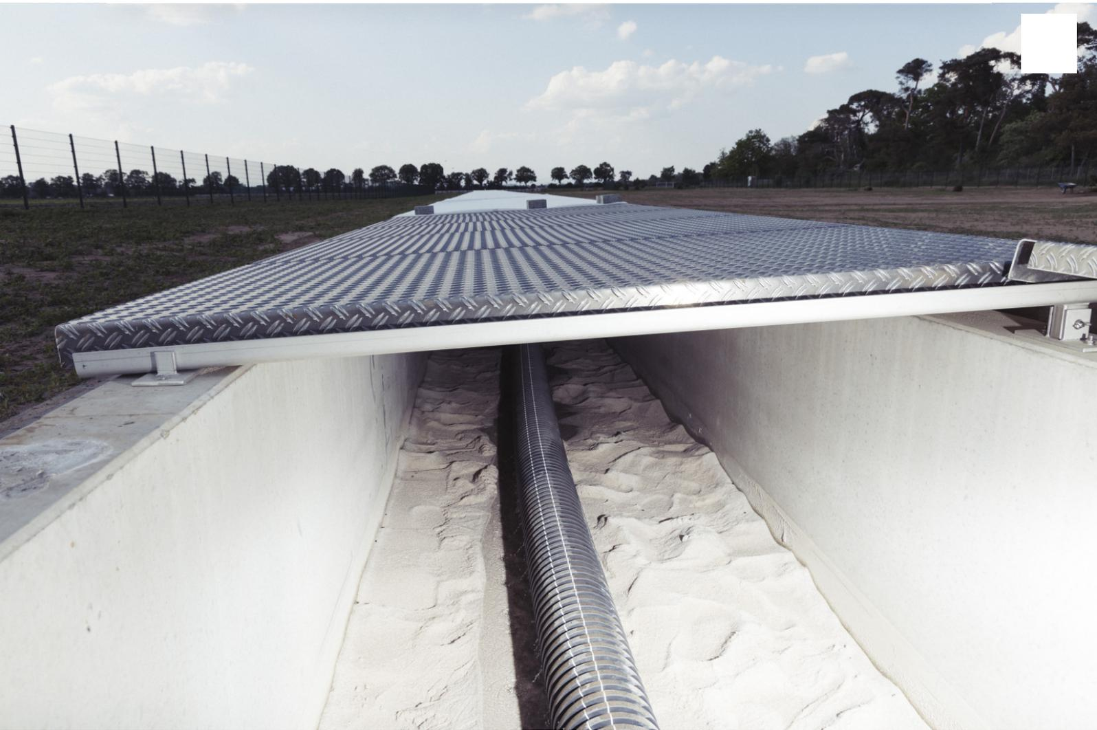
Rund 140.000 Liter Wasser aus dem Rhein sickern aus diesem Rohr stündlich in den Boden des Hessischen Rieds. Wird so der Boden ausreichend vernässt, wenn der Regen ausbleibt? (Foto: Ivo Mayr / CORRECTIV)
