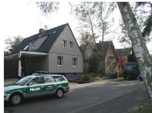
St. Ingberter Straße 13 / 15
