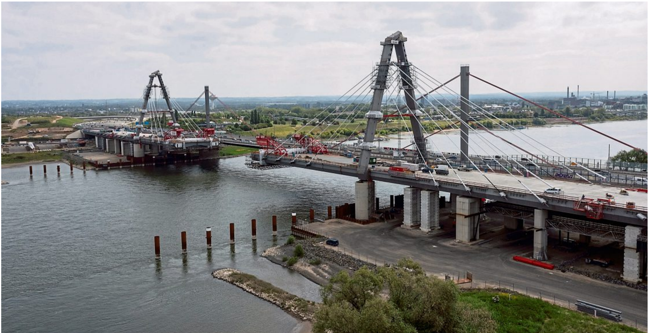
Meter für Meter wächst der erste Teil der neuen Leverkusener Rheinbrücke zusammen. Im September soll die Lücke geschlossen sein.
